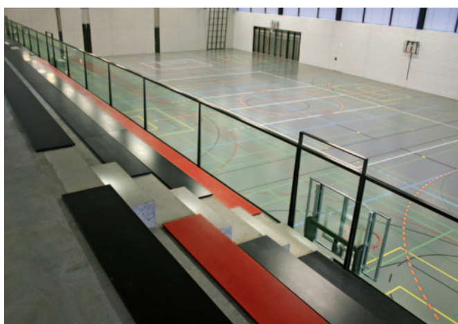
Absturzschutz einer Zuschaueranlage mit Verbund-Sicherheitsglas, freie Sicht auf die Spielfelder
